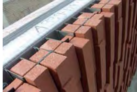
Prefabricatie van bouwcomponenten: gevelbekleding
